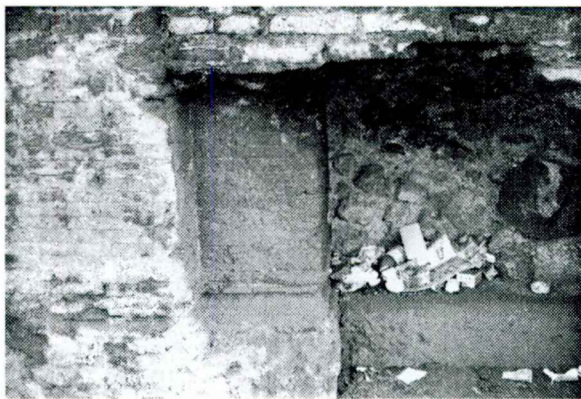
Fig. 5: Piedritto sinistro della porta settentrionale (foto G. Cavillier).
