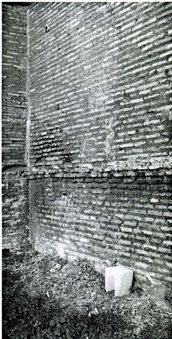
Fig. 8: La "cornice" nel tratto di mura aureliane in prossimità di Piazza della Croce Rossa (foto G. Cavillier)
